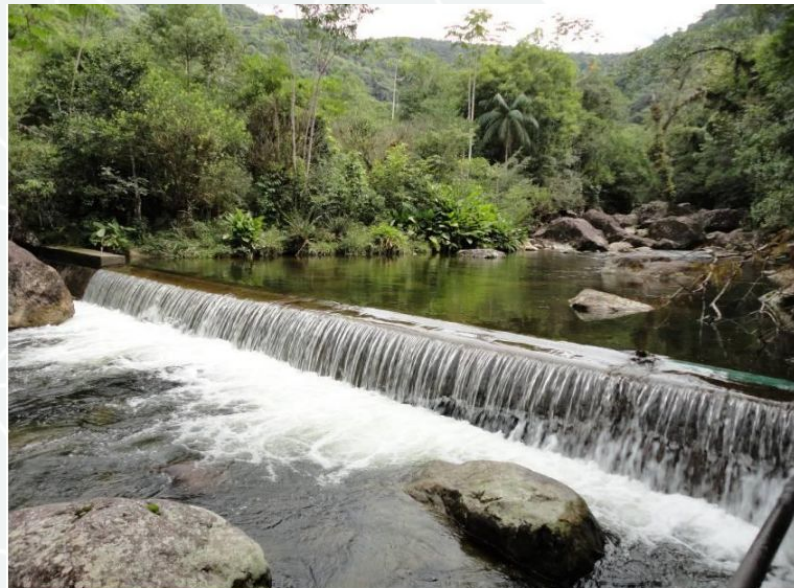
Captação de água bruta - barragem de nível em concreto armado. Fonte: Visita Técnica STE, 2010.
