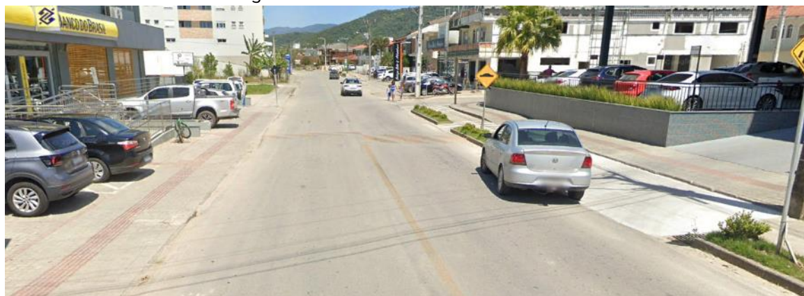
Figura 173. Avenida João Antônio Besen.
