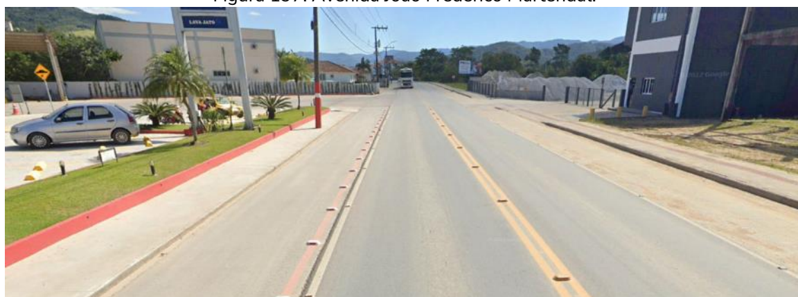
Figura 197. Avenida João Frederico Martendal.
