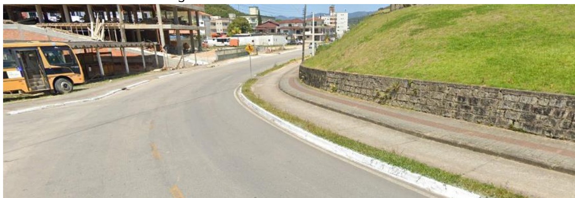
Figura 196. Avenida João Antônio Besen.
