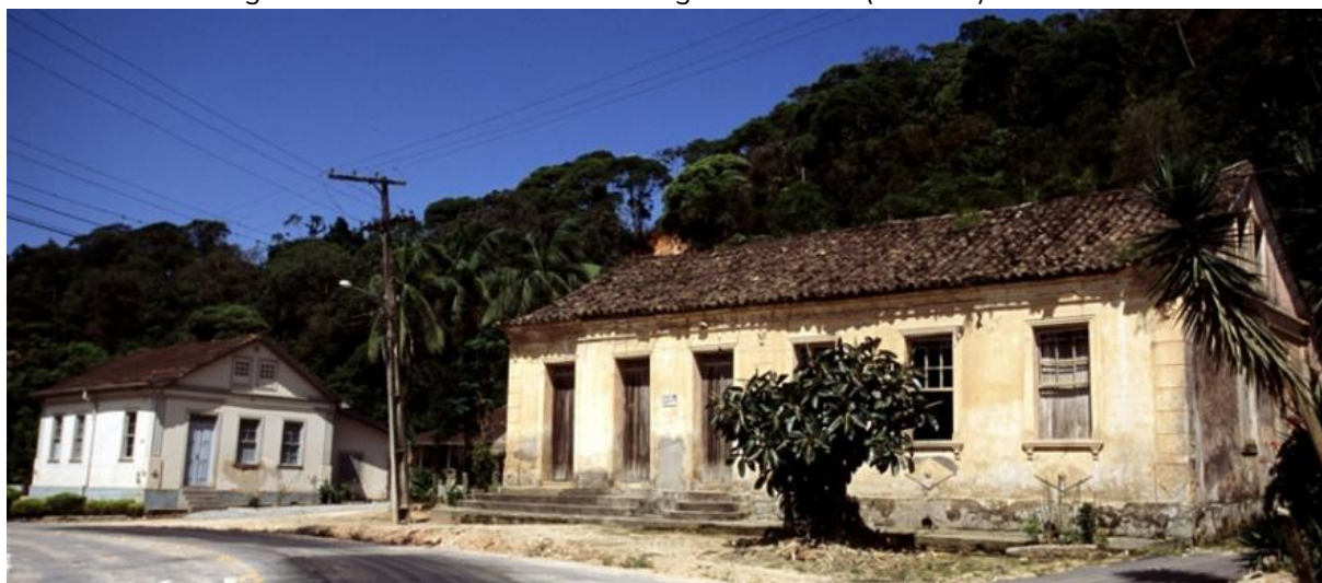
Figura 76. Casa e armazém Freiberg. O armazém (à direita) demolido
