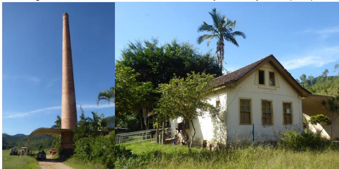
Figura 77. Chaminé da Usina Pirabeiraba e construção de serviço anexa (1965).
