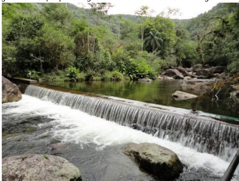
Figura 132. Captação de água bruta no Rio Farias com barragem de nível
